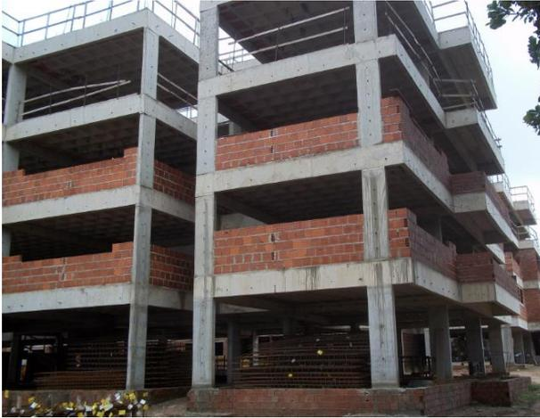
**Figura - 3:** Alvenaria de vedação.
