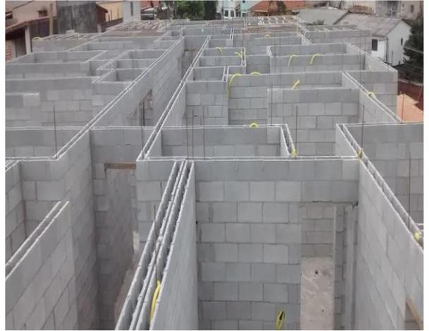
**Figura - 4:** Alvenaria estrutural.
