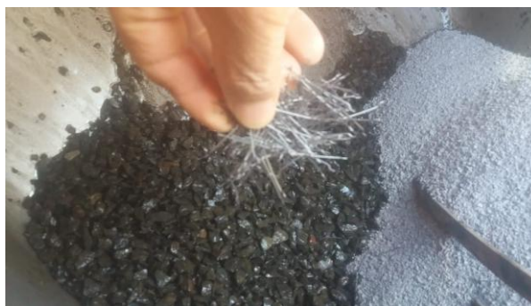
Figura 3 – Colocação da fibra.
