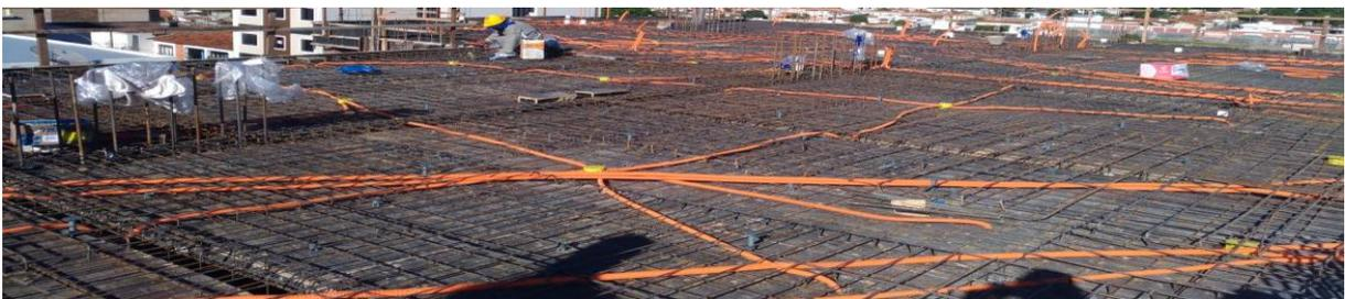
**Figura 3:** Laje maciça pronta para receber a concretagem
