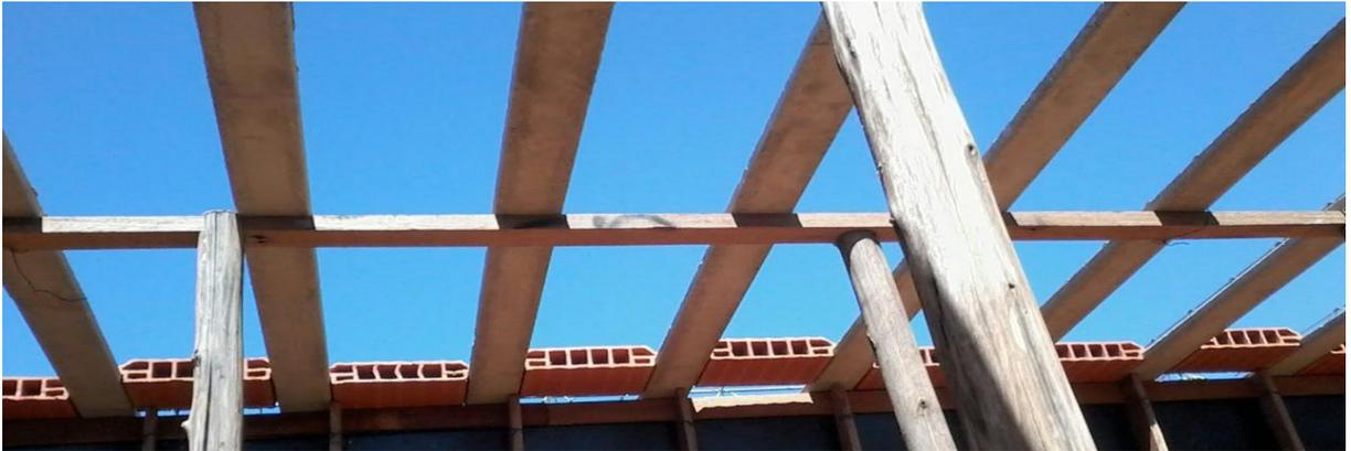
**Figura 4:** Escoramento e montagem das vigotas treliçadas para laje com lajotas cerâmicas
